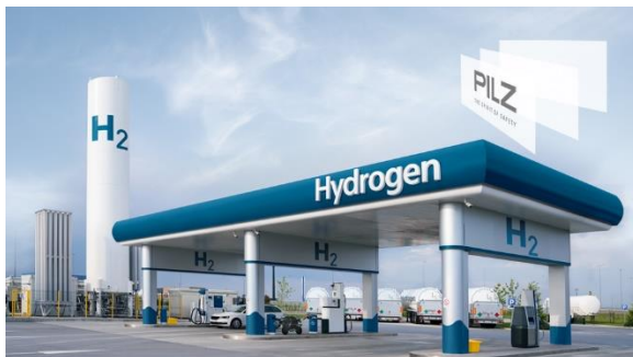
Pie de foto: las funciones de seguridad típicas de una estación de repostaje de hidrógeno son la detección de fugas de hidrógeno, de llamas y de humo y la supervisión de temperatura y presión. Copyright: © iStock.com/Scharfsinn86, © Pilz GmbH & Co. KG
